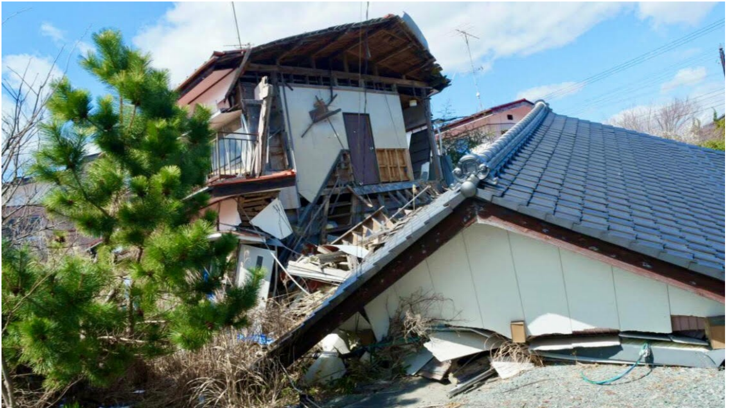
Bernardが福島第一原子力発電所から3マイル以内で撮影した福島地震後の写真。
